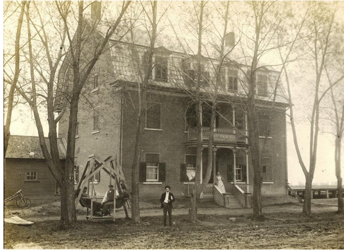
Maison Gélinau Rue Beauchemin (aujourd’hui rue Girouard)
