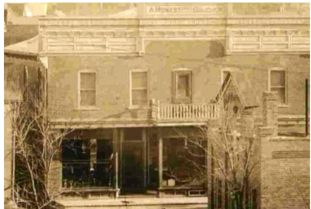
Boucherie d'Auguste Monast Bâtisse construite entre 1891 et 1907
